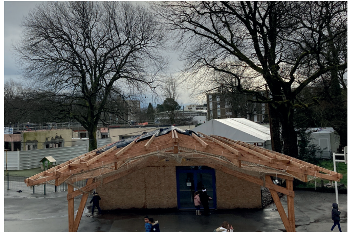
La cité de chantier et future bibliothèque de l'école Georges Leygues
