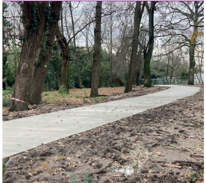
Voie verte du Pontet Sud
